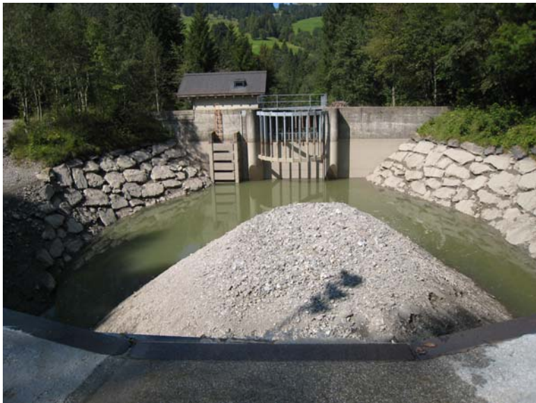
Gefüllter Geschiebesammler, WSL-Messstation Erlenbach. Quelle: Archiv WSL
