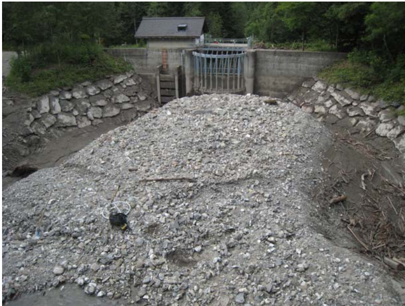
Bild: Gefüllter Geschiebesammler im Erlenbach. Archiv WSL.
